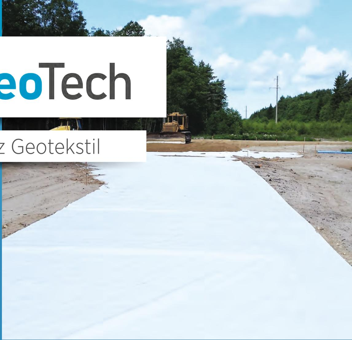
**Jeotech PP Örgüsüz Geotekstiller**, milimetreden çok daha ince saf polipropilen esaslı elyafların iğnenmesi ve ısıtma işlemi uygulanması yöntemiyle beyaz renkli olarak üretilen, örgüsüz tekstil ürünüdür.
